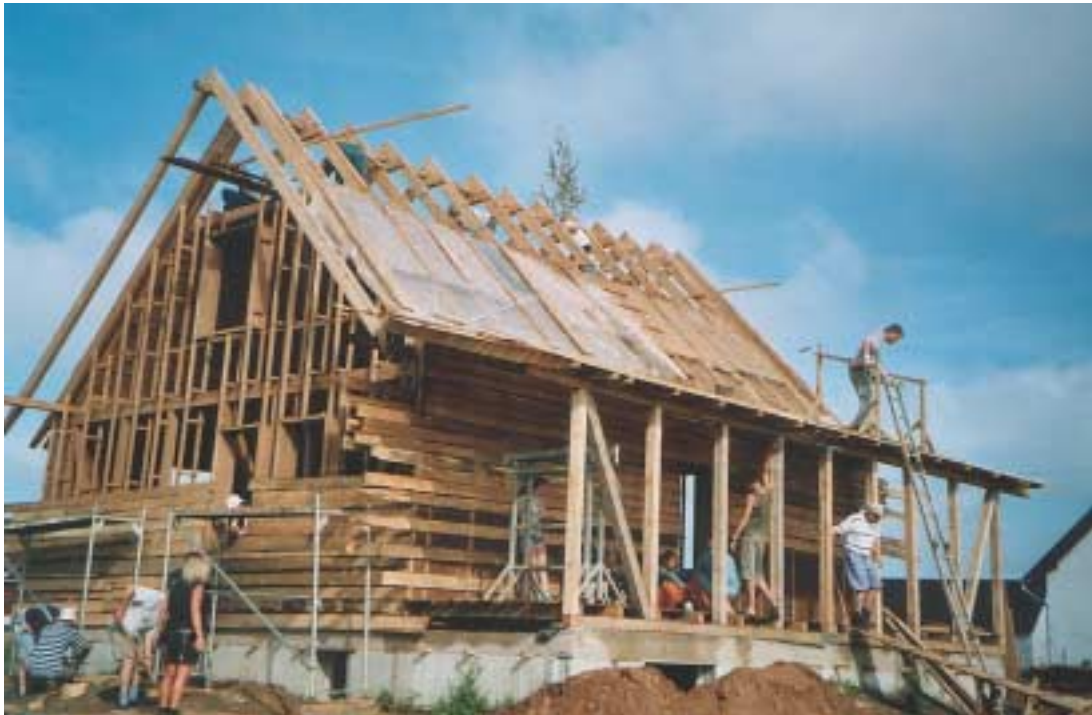
- Bau des Hauses Nr. 13 im Workcamp II 2005 -
