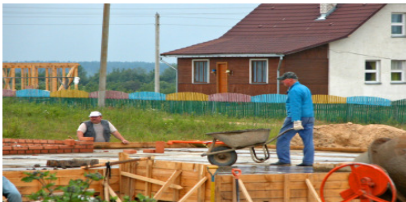
Baubeginn 2008 in Stari Lepel mit dem Dorfgemeinschaftshaus als Niedrig-Energie-Haus, im Hintergrund links Ständerwerk für Haus Nr. 20
